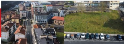
Obras: Aizkorri kalea.
